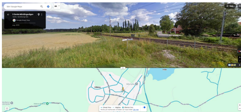
Figur 5 Google streetview, spårväxelområde
